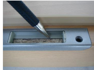
Schließblech wieder einschieben und anzeichnen
