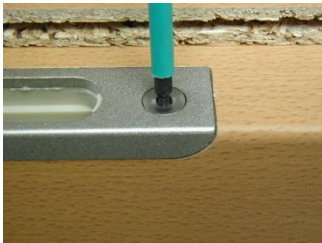
und an den Z- Winkeln mit den Inbusschrauben befestigen
