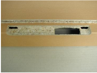
fertig ausgestemmtes Riegelloch
