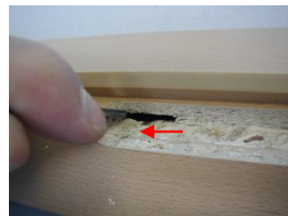
Beide Öffnungen nach außen mit 6 mm Stechbeitel vergrößern
