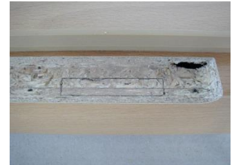
Schließblech wieder einschieben und anzeichnen
