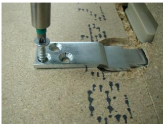
Erst je Winkel nur eine Schraube, dann !Überprüfen Sie, ob alles passt!
