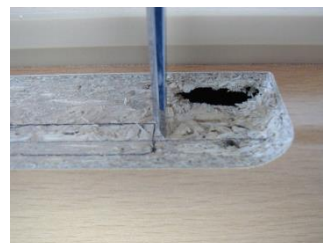
Angezeichnetes Riegelloch etwa 2 mm nach oben/unten und hinten größer ausstemmen
